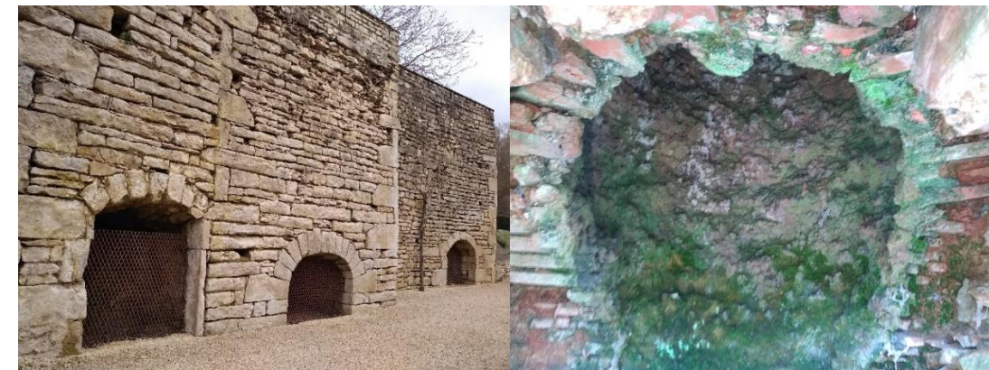
Figure 64 : Entrée des fours à chaux et photo de l'intérieur de l'un d'entre eux.
