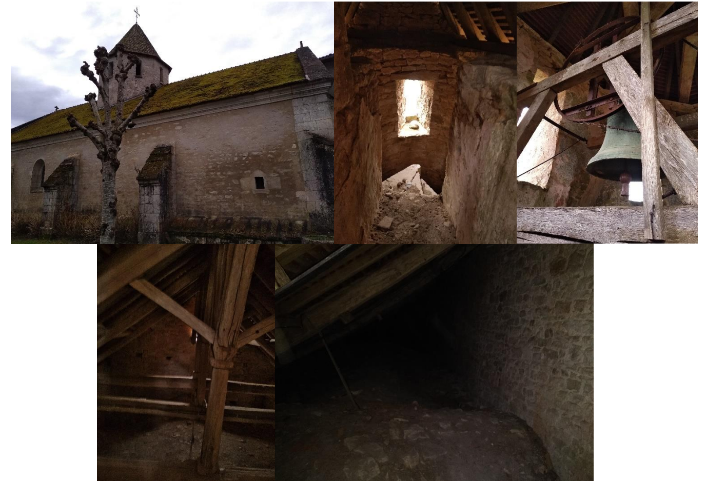
Figure 66 : Église de Lizant. Dans l'ordre de lecture : vue de l'extérieur, les escaliers, le clocher, les premiers combles et les combles moins accessibles aux oiseaux.
